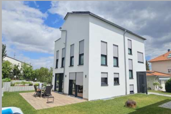
S-Feuerbach, Hohewartstr. 162 B (Einfamilienhaus, BJ 2023)
