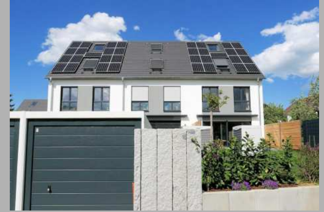
S-Heumaden, Opalweg 17-29 + Kemnaterstr. 87 (10 Reihenhäuser in 3 Abschnitten, BJ 2017)
